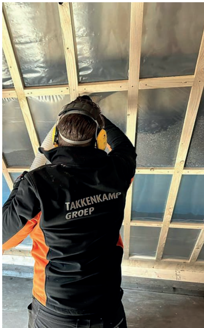
Inblazen van vezelmateriaal in het testhuisje.
